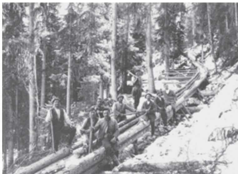
Iral heissen die Holzriesen auf Romanisch. Erst diese aufwändigen Transportkonstruktionen ermöglichten die Holznutzung. Foto: Rudolf Grass
